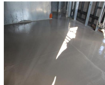
自流平材料现场泵送施工
