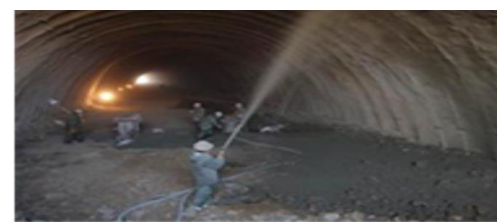
喷射混凝土的应用
